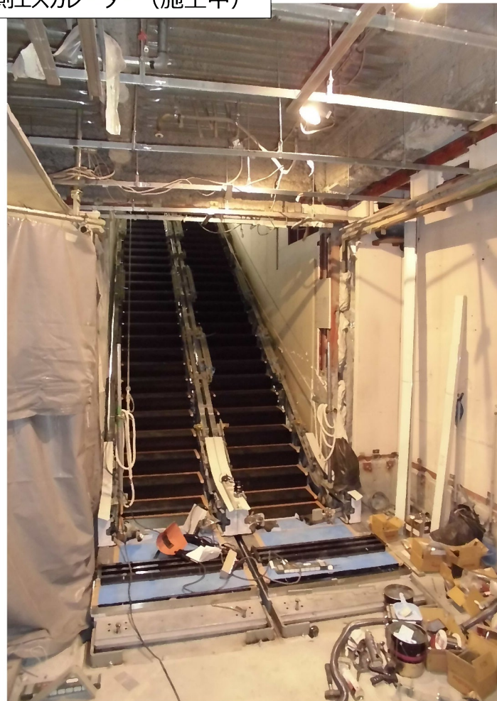
①北側エスカレーター（施工中）
