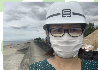
護岸工事視察
